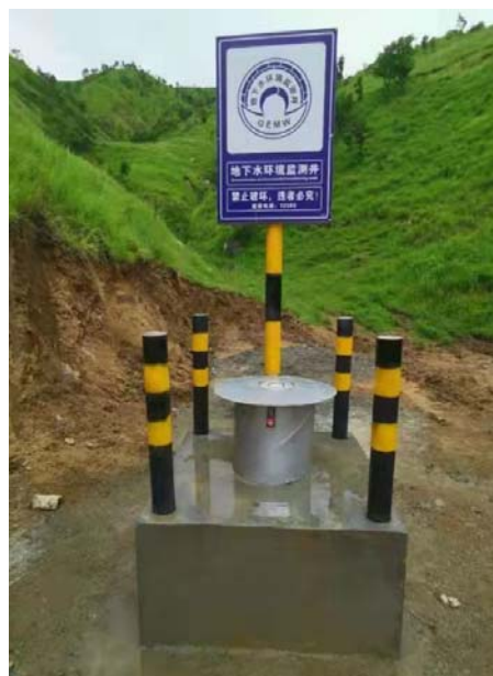
尾矿库上游地下水监测井
