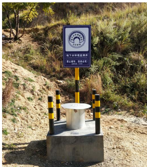
尾矿库右岸坝肩地下水监测井
