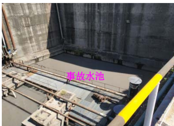
1号泵站事故水池
