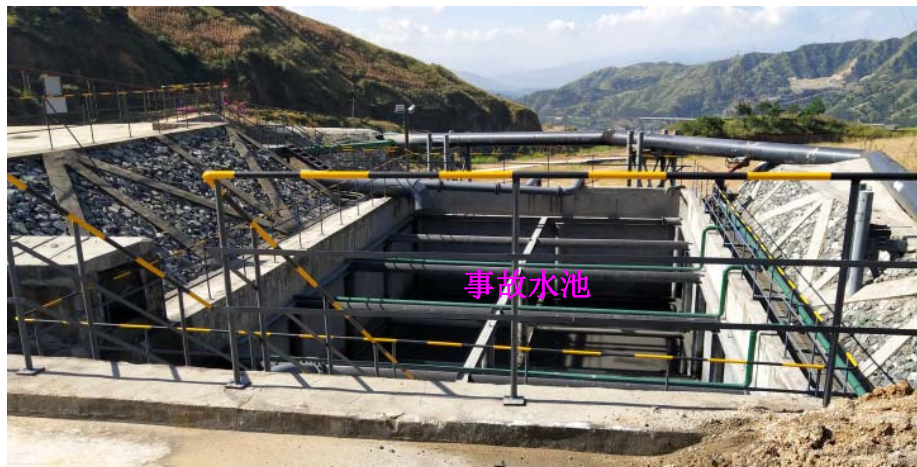
3号泵站事故水池
