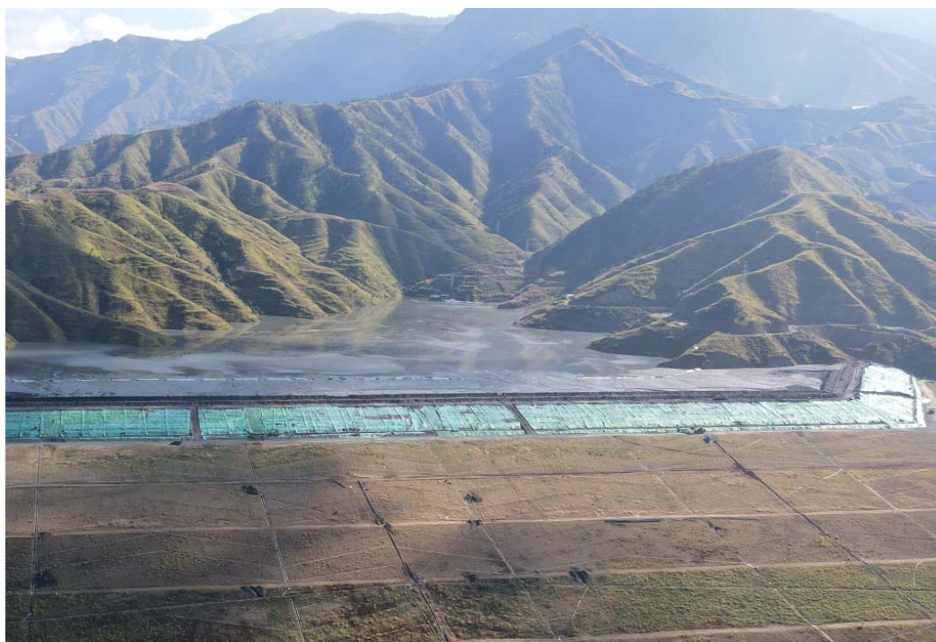
尾矿库放矿子坝作业平台及内、外坡面、干滩面现状照片
