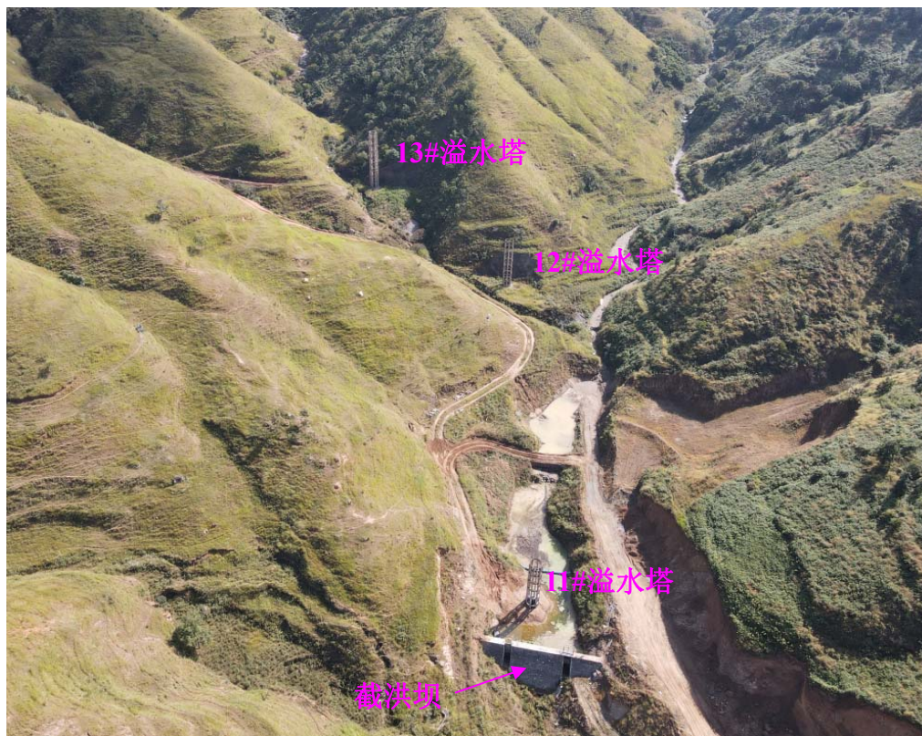
溢水塔、截洪坝照片
