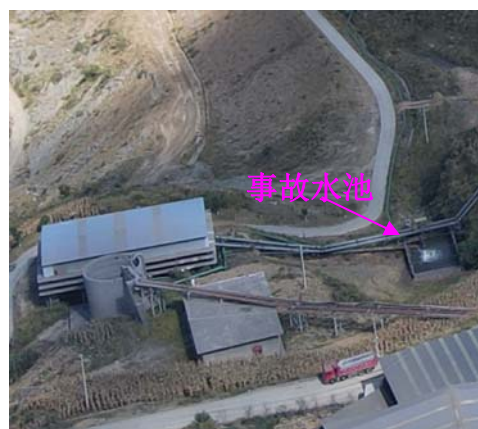
2号泵站事故水池
